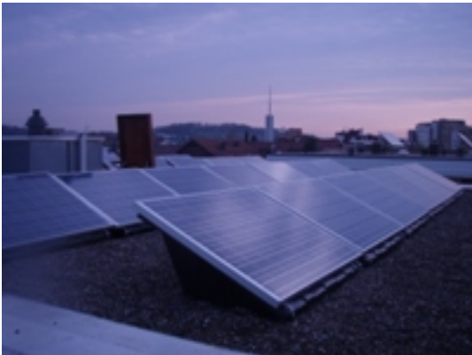
Flachdach in S-Weilimdorf
