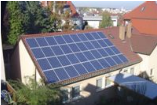
Einfamilienhaus in S-Feuerbach
