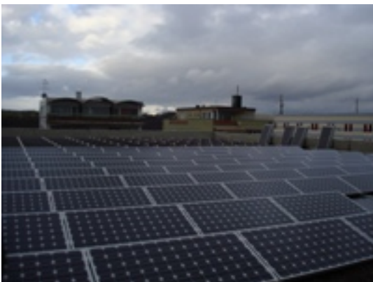
Flachdach in Ostfildern
