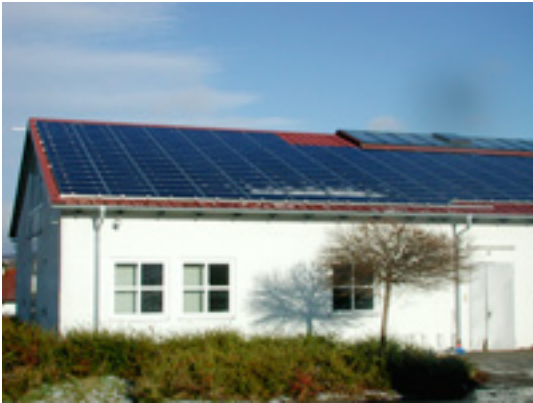
Dünschichtanlage in Stetten a.k.M.
